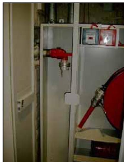
*Einspeisung und Entnahme des Löschwassers*
