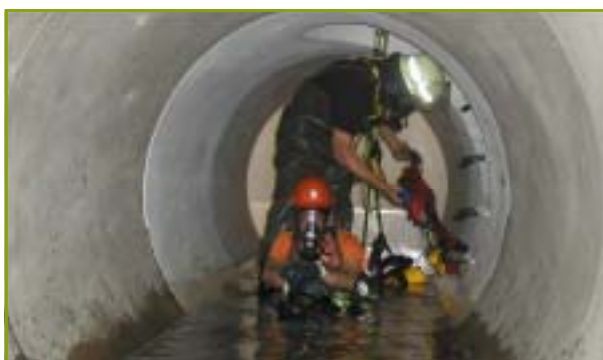
Übung: In der Düsseldorfer Unterwelt muss ein Arbeiter des Kanal- und Wasserbauamtes aus der Kanalisation gerettet werden.
