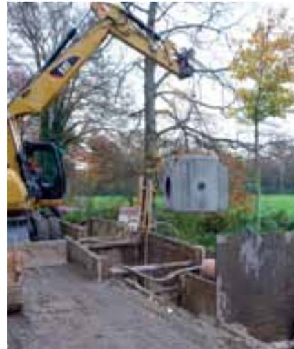
Mit dem 1.290 m langen **SAMMLER WITTLAER** wird seit 1981 das klärflichtige Abwasser von Düsseldorf-Wittlaer zur weiteren Abwasserbehandlung nach Duisburg übergeleitet. Auf einer Länge von ca. 840 m verläuft der Kanal DN 400 im Schutzrohr durch eine Wasserschutzzone. Hier bedurfte es in diesem Jahr, infolge geänderter Betriebsauflagen, des Rückbaus bestehender und Einbaus zweier neuer Revisionschächte, die nun Unterhaltungsabschnitte von 280 m Länge ermöglichen.
