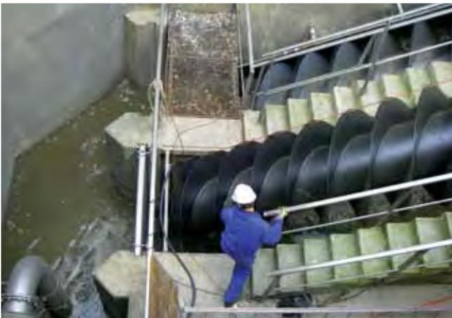
Ebenso wird im Einlauf des **KLÄRWERKS MONHEIM** das Abwasser der Stadt Monheim zunächst durch ein Pumpwerk auf die Höhe des Zulaufkanals aus Langenfeld gehoben. Dieses besteht aus zwei Schneckenpumpen; einer kleineren für den Trockenwetterzufluss und einer größeren für die Regenwetterzuflüsse. Auch in diesem Fall musste verschleißbedingt ein Austausch der Trockenwetterschnecke erfolgen.
