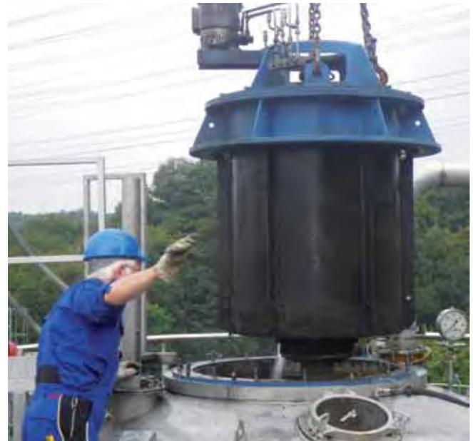
Im Frühjahr musste das Gasdruckerhöhungsgebläse auf dem **KLÄRWERK SOLINGEN-GRÄFRATH** ausgetauscht werden. Das Gebläse war stark verschlissen und entsprach auch nicht mehr den heutigen Explosionsschutzrichtlinien.
