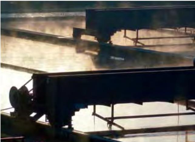
Für die Schlammräumung in Längsbecken gibt es unterschiedliche Räumersysteme. Neben den in Hilden eingesetzten Schildräumern kommen u.a. auch Bandräumer zum Einsatz. Hierbei erfolgt die Schlammräumung mittels Räumebalken, die an einer umlaufenden Kette befestigt sind.
