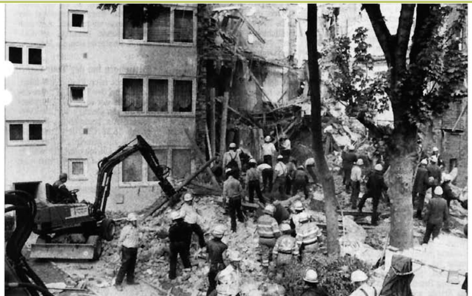
Während die Helfer zunächst verstärkt von der Vorderseite des eingestürzten Hauses nach Überlebenden gesucht hatten, konzentrierten sie sich am Nachmittag mehr auf den Hinterhof zwischen Krahestraße und Mettmanner Straße.
