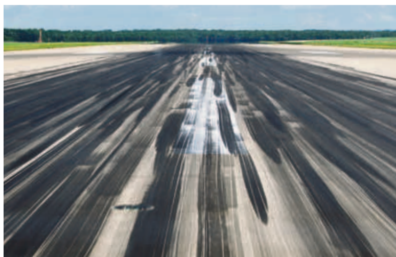
Der Gummiabrieb muss regelmäßig von den Start- und Landebahnen entfernt werden.
