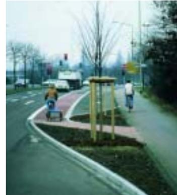
Fahrbahnrand vorgezogen werden. Alternativ hierzu kann der Radweg etwa 10-20 m vor der Einmündung analog einem Radwegende in einen Radfahrstreifen überführt werden. Zumindest ist das Längsparken frühzeitig zu unterbinden, um den Sichtkontakt zu gewährleisten.
