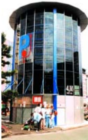
Automatische Fahrradparkanlagen lassen sich den räumlichen und städtebaulichen Rahmenbedingungen entsprechend anpassen. Sie sind bei einer Nachfrage von ca. 100 – 500 Bike&Ride-Nutzern pro Tag geeignet.
