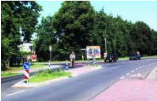
von Kreuzungen und Einmündungen liegen. Hierzu bietet sich die Einrichtung gesonderter und unter Berücksichtigung der Fahrdynamik von Radfahrern gestalteter Querungsstellen an. Ist die Anlage einer gesonderten Querungshilfe nicht möglich, sollten zumindest noch die Furten durchgängig im Zweirichtungsverkehr nutzbar sein.
