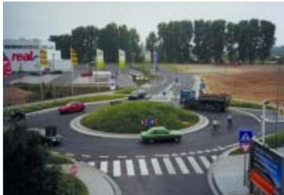
Eine sichere Radverkehrsführung ergibt sich daher durch kompakte und mini Kreisverkehrsplätze mit einem Außendurchmesser von etwa 30 bzw. 25 m und einstreifigen Zu- und Ausfahrten, die in den letzten
