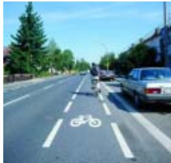
Werden die Radfahrer auf der Fahrbahn mittels Radfahrstreifen oder Schutzstreifen geführt, muss auch hier ein markierter Sicherheitsstreifen angelegt werden, wenn Konflikte, wie z.B. parallel verlaufender Parkstreifen mit der Gefahr des Öff-
