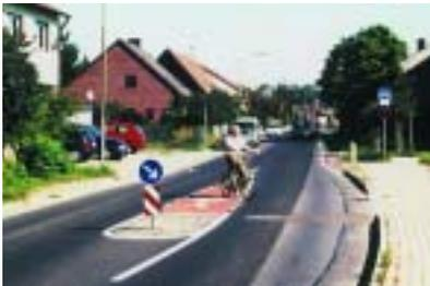
bei der Querung von Seitenraum zu Seitenraum vorzusehen sind, in der Regel nicht angebracht. Das direkte Linksabbiegen sollte mit speziellen Abbiegestreifen für Radfahrer gesichert werden. Nach Möglichkeit sollte der Abbiegestreifen für die Radfahrer baulich oder durch Markierungen hervorgehoben werden.
