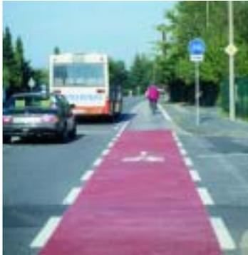
An Busbuchten verlaufen die Radfahrstreifen grundsätzlich ohne Unterbrechung links der Busbucht.
